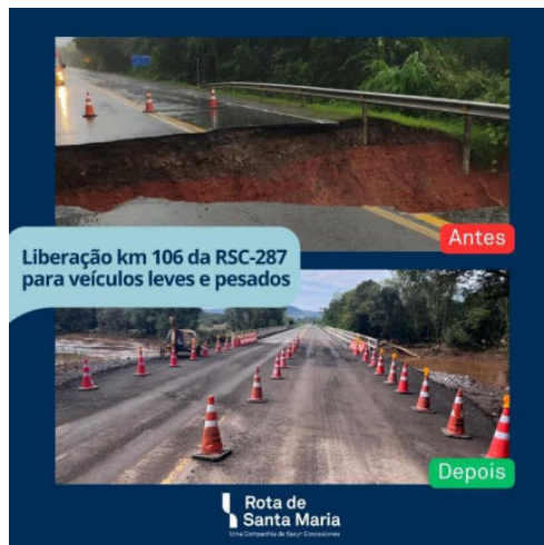
(km 106 – obra que reabriu a ligação entre Santa Cruz do Sul e Vera Cruz)
