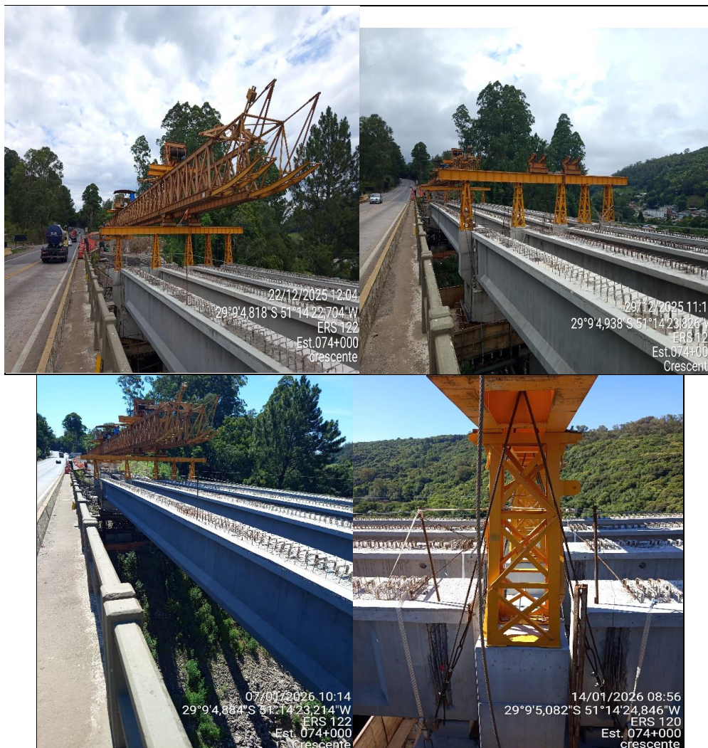
Foto 21 a Foto 24 - A estrutura do pilar P06 desenvolveu-se de lenta sobre a estrutura entre 19/12/2025 e 16/01/2026.
