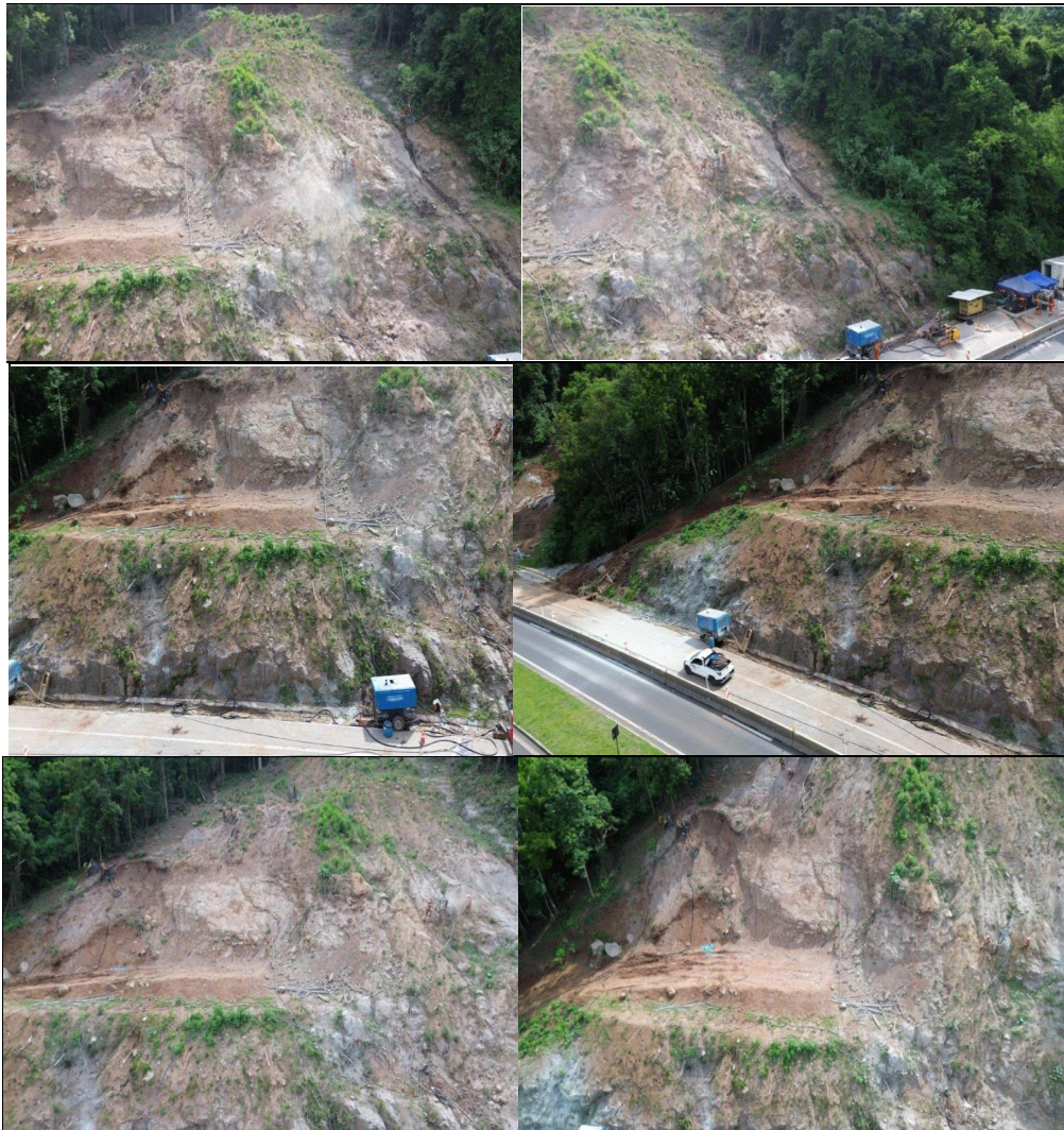
Foto 51 a Foto 55- Desenvolvimento dos trabalhos de perfuração para atirantamento e drenagem do maciço em 14/01/2026.
