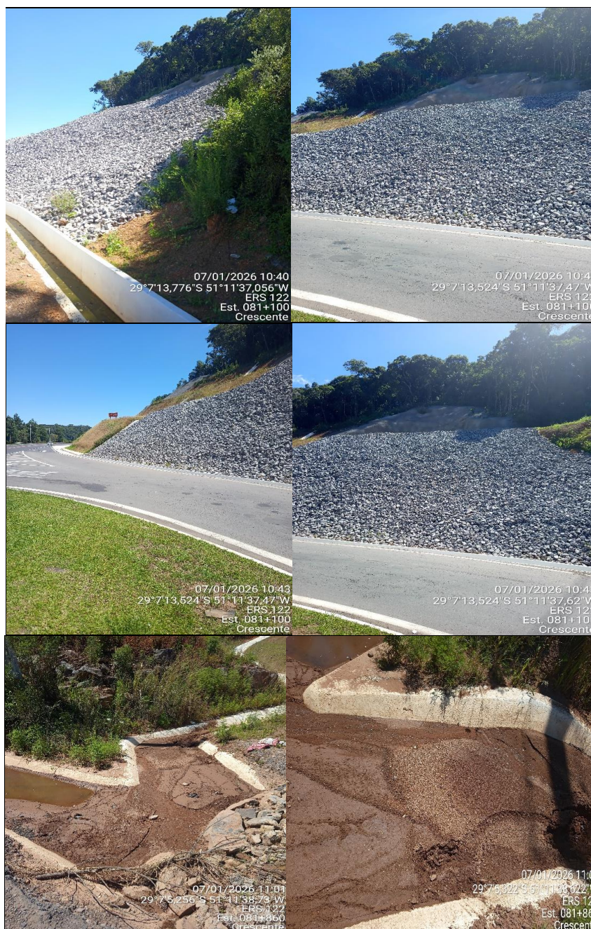
Foto 56 a Foto 61- Visão geral da contenção em 07/01/2026.
