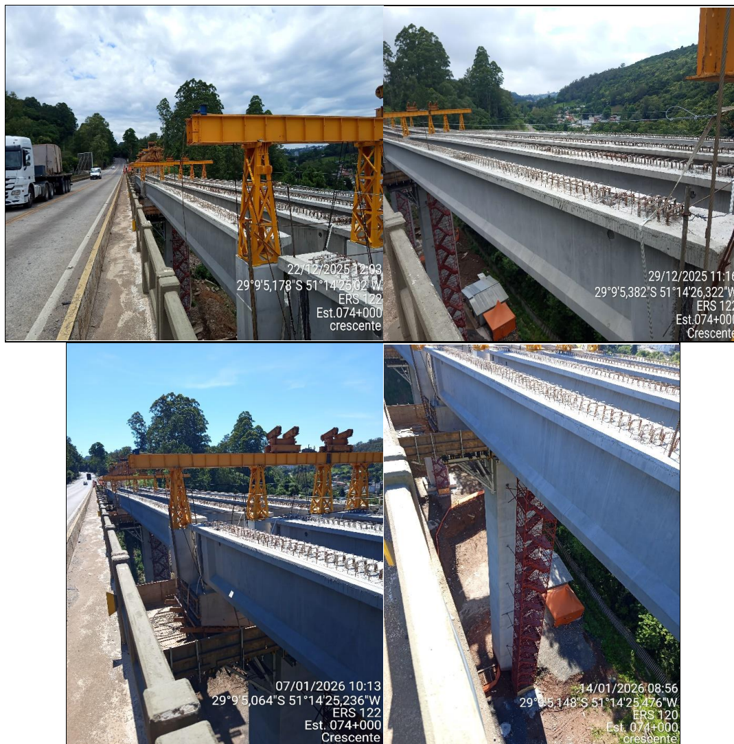
Foto 17 a Foto 20- A estrutura do pilar P05 desenvolveu-se de forma lenta sobre a estrutura entre 19/12/2025 e 16/01/2026.
