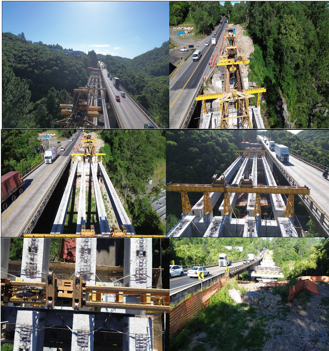
Foto 31 a Foto 36- Vista das longarinas e sistema de plataforma de lançamento em 20/12/2025.
