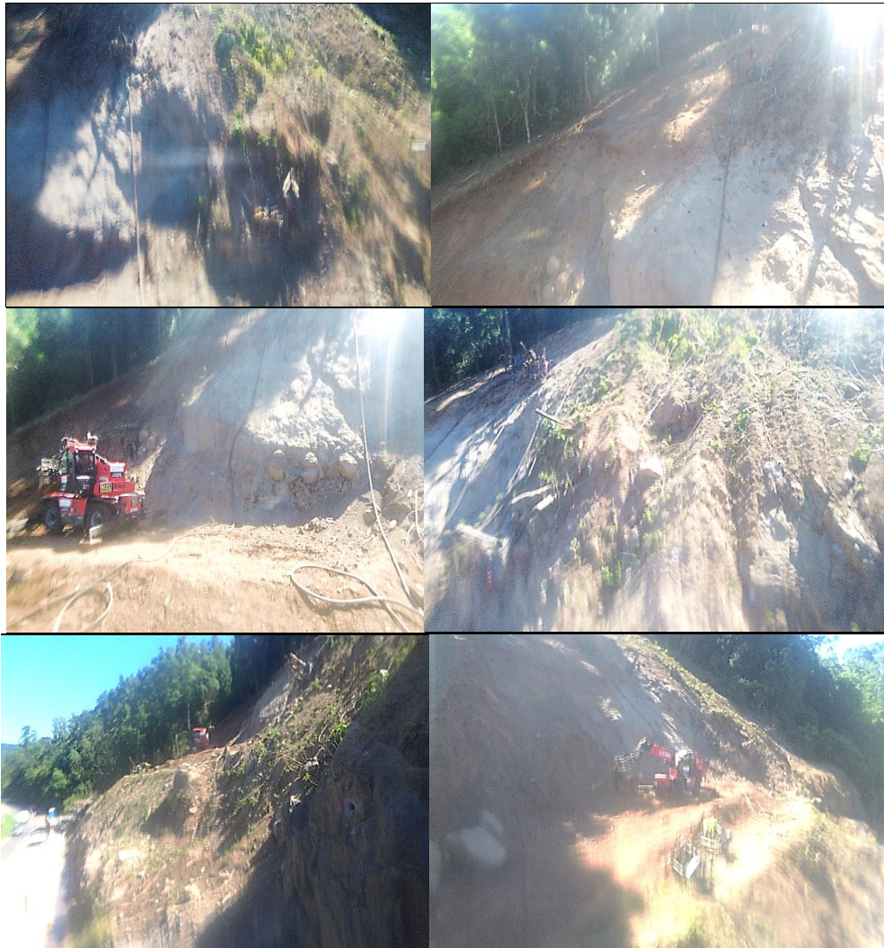
Foto 45 a Foto 50 - Desenvolvimento dos trabalhos de perfuração para atirantamento e drenagem do maciço em 20/12/2025.
