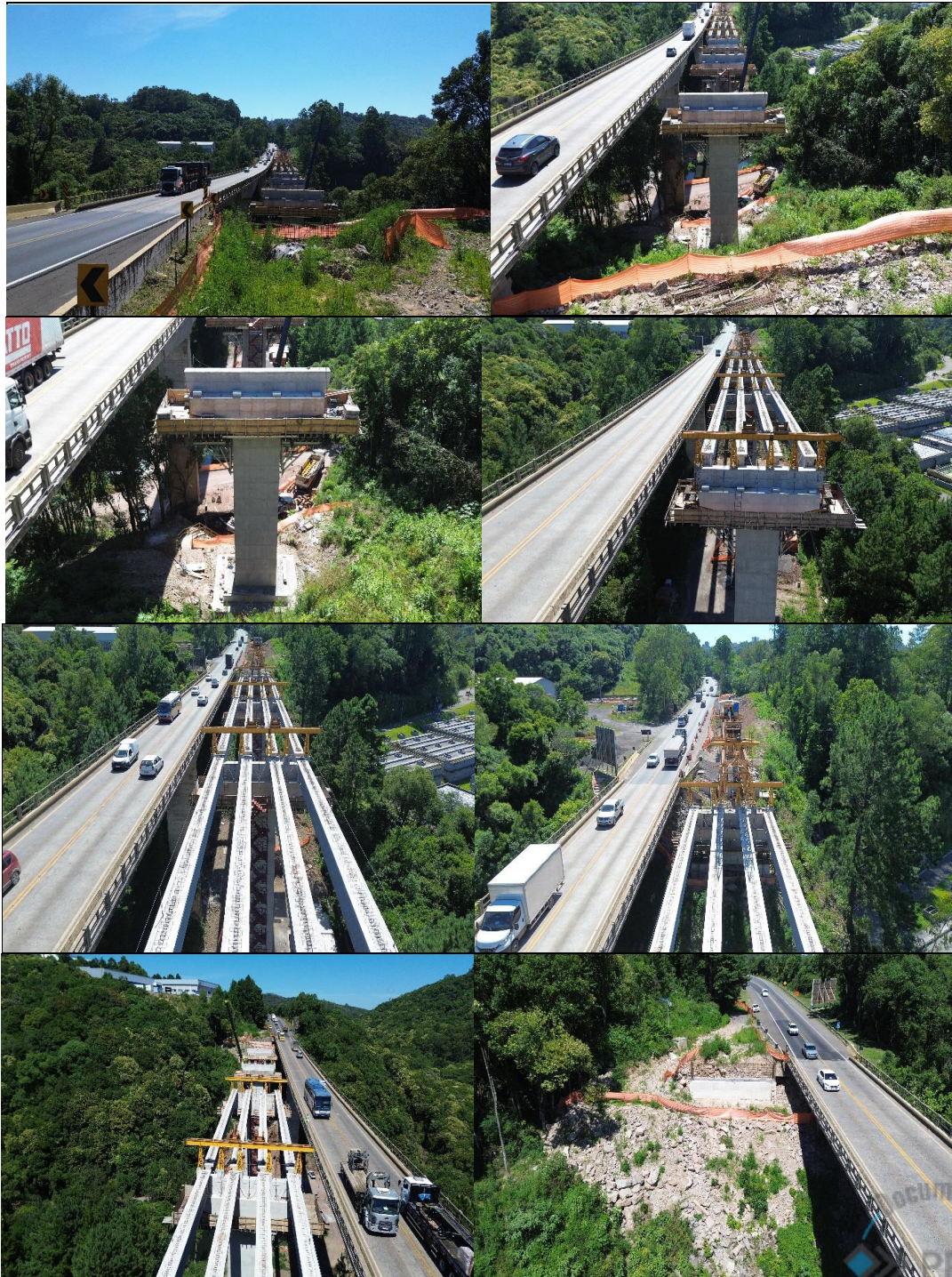
Foto 37 a Foto 44- Vista das longarinas e sistema de plataforma de lançamento em 07/01/2026.
