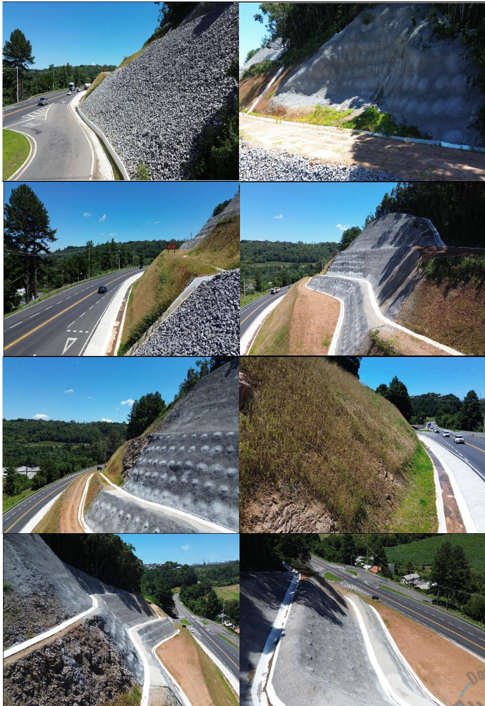
Foto 62 a Foto 69 - Visão geral da contenção em 07/01/2026.
