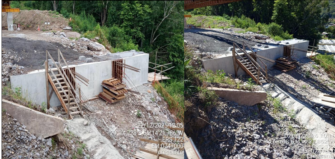
Foto 29 e 30- O bloco do pilar 08 – encontro 02, não apresentou desenvolvimento entre 19/12/2025 e 16/01/2026.
