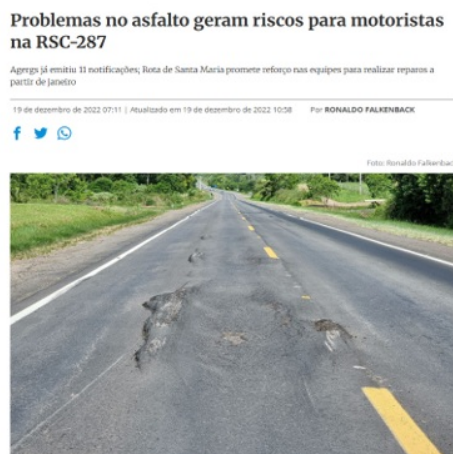
Figura 1 – Reportagem veiculada em 19 dezembro de 2022: “Problemas no asfalto geram riscos para motoristas da RSC-287”
